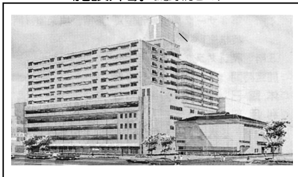
施設外観（鷹野橋ビル）
