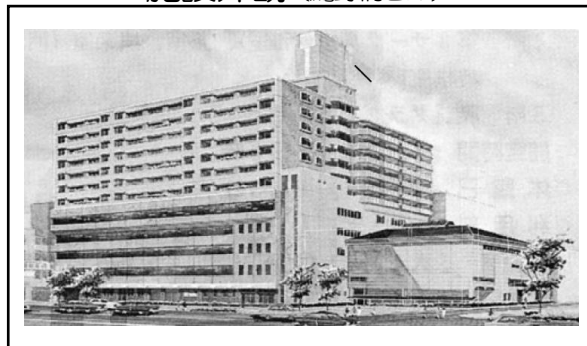
施設外観（鷹野橋ビル）
